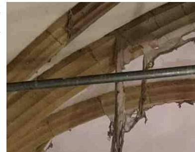
Nettoyage des pierres à l'aide d'un produit à base de latex
